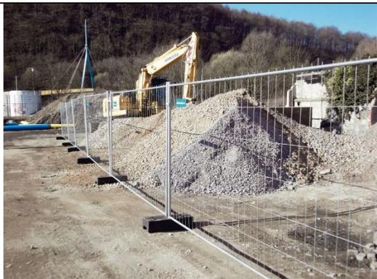
Exemple de clôture mobile Heras utilisée sur les chantiers
